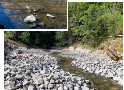
Wehr Weida im Juni 2022, die Wehranlage wurde abgebrochen und eine Niedrigwasserrinne im Gewässer profiliert
