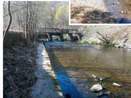
Wehr Weida im Juni 2022, die Wehranlage wurde abgebrochen und eine Niedrigwasserrinne im Gewässer profiliert
