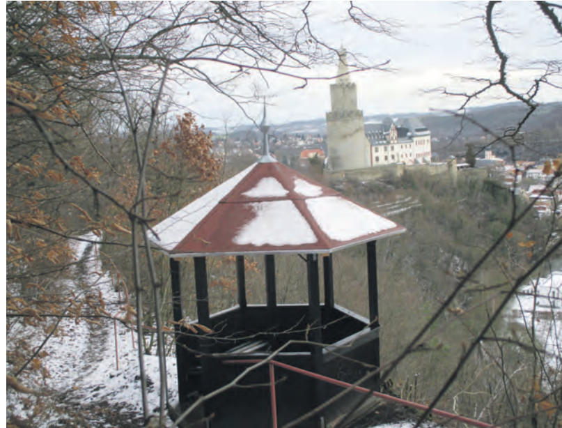
Im Januar haben die drei Herren noch eine kleine Turmspitze auf das Dach gesetzt.
