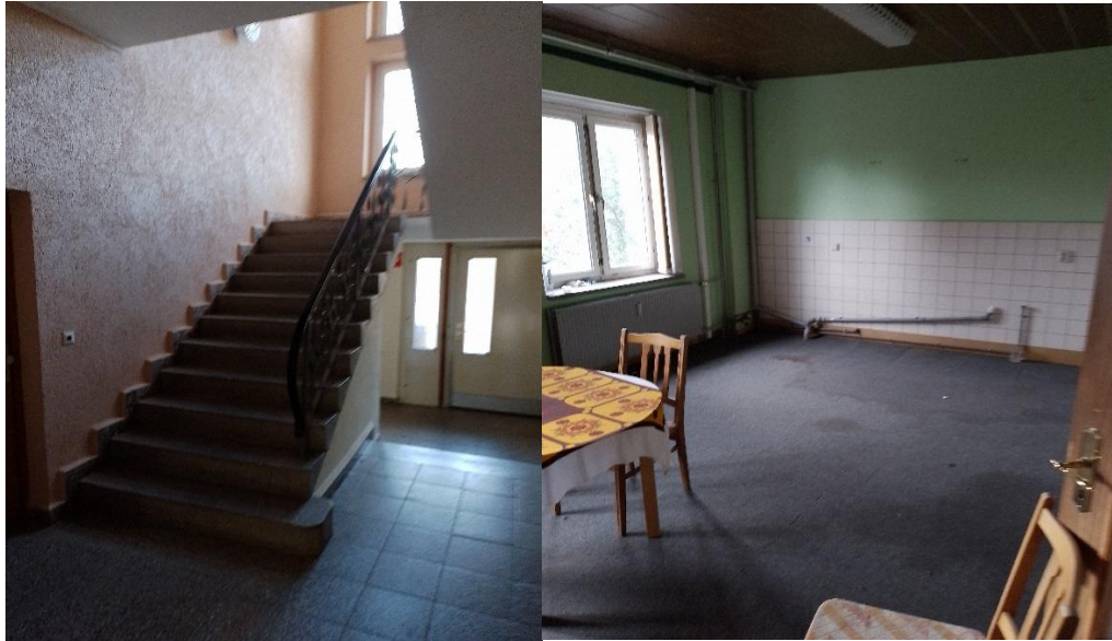
Treppenaufgang zum Obergeschoss
