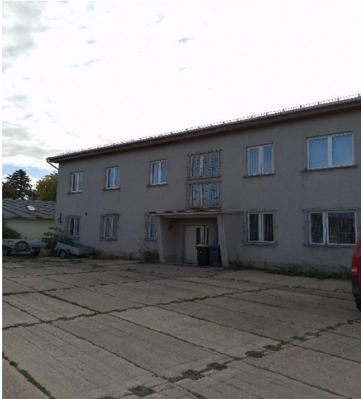
Rückseite des Gebäudes
