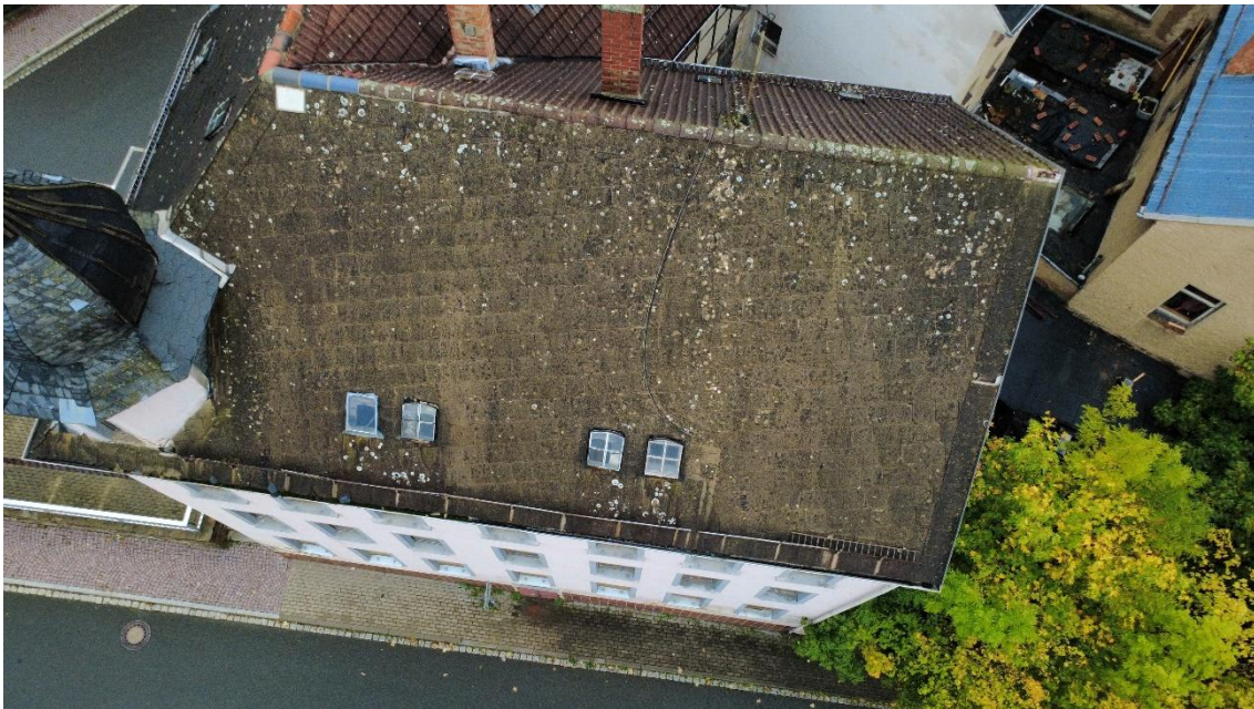
Dach (Seite Greizer Straße)
