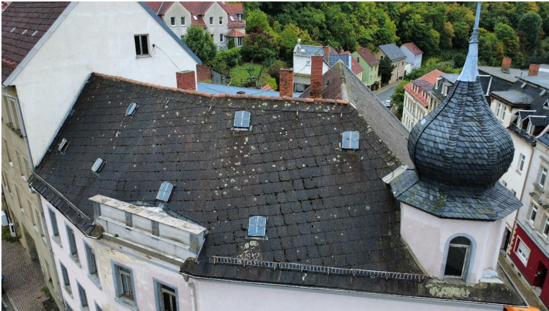
Dach (Seite Wiedenstraße)
