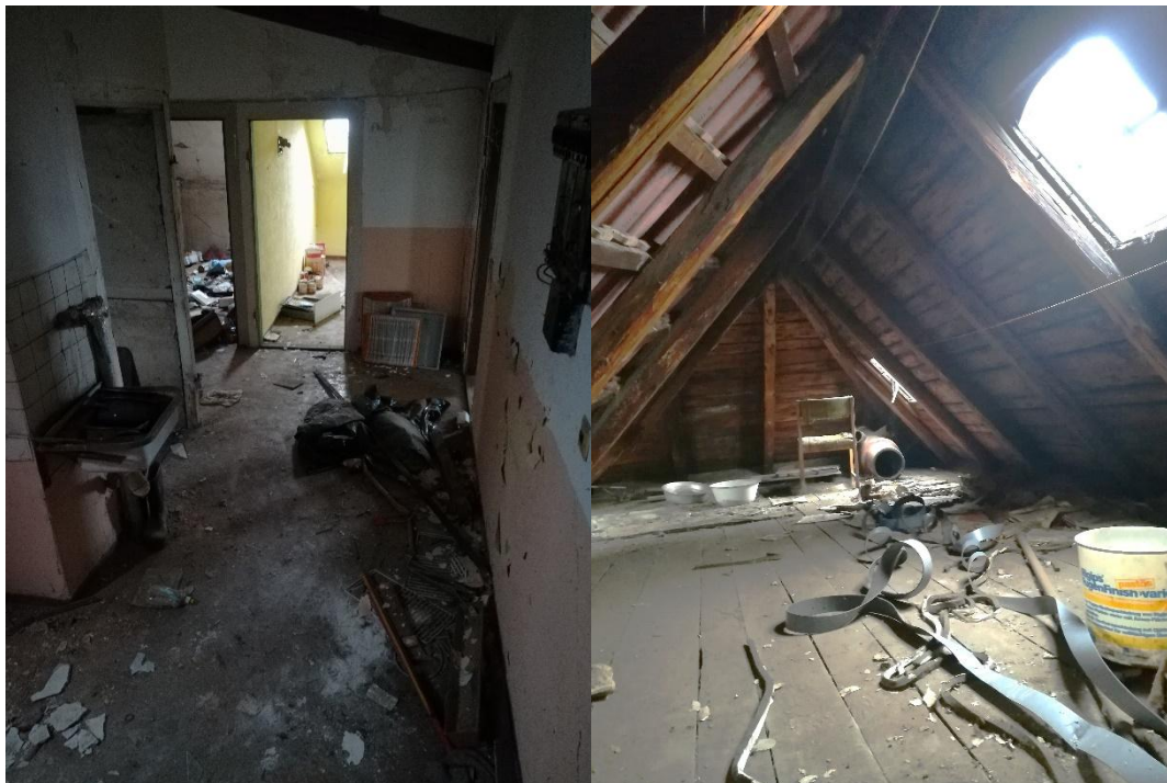
Dachgeschoss und Dachboden
