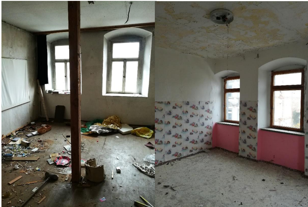
Wohnräume in den Obergeschossen
