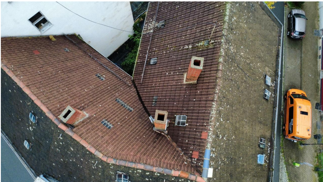
Dach (von oben)
