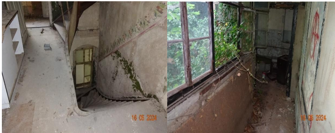
Treppe zu oberen Stockwerken + Laubengang
