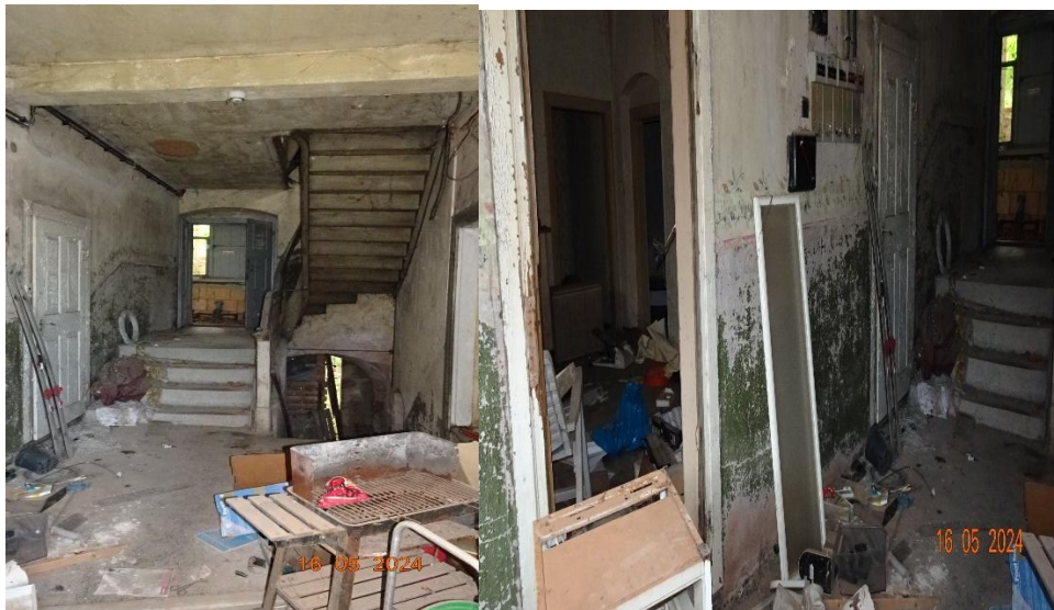
Eingangsbereich und Wohnung EG
