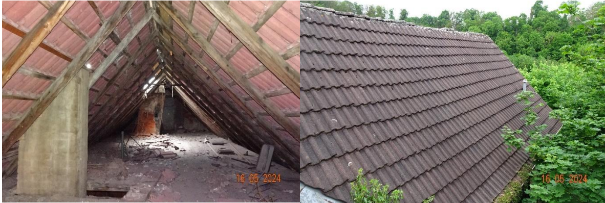
Spitzboden und Dach
